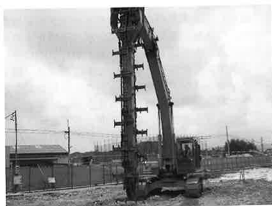
写真2. 工場跡地の原位置浄化 (静岡県内)
