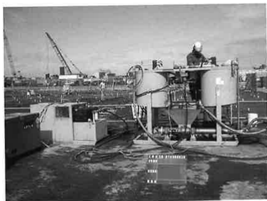
写真1. 製油所跡地の原位置浄化 (神奈川県内)
