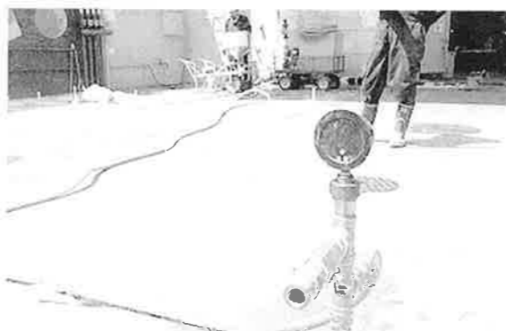
写真3 消臭剤の注入
